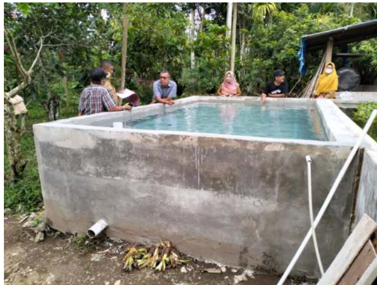
Rehab Kolam Pokdakan
