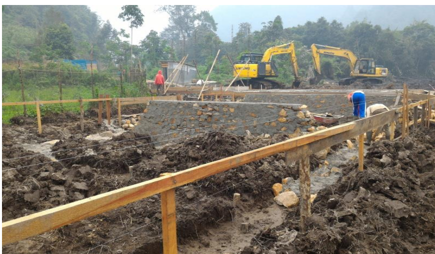
Extensifikasi kolam baru dengan memanfaatkan escavator
