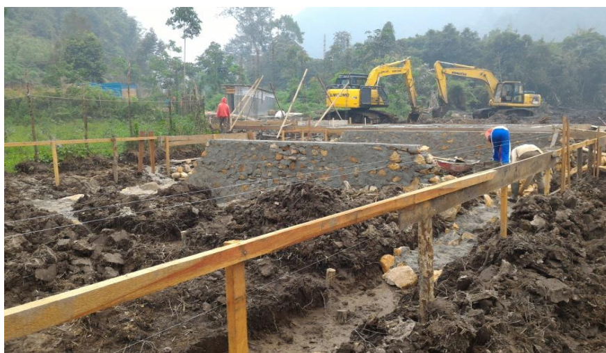
Extensifikasi kolam baru dengan memanfaatkan escavator
